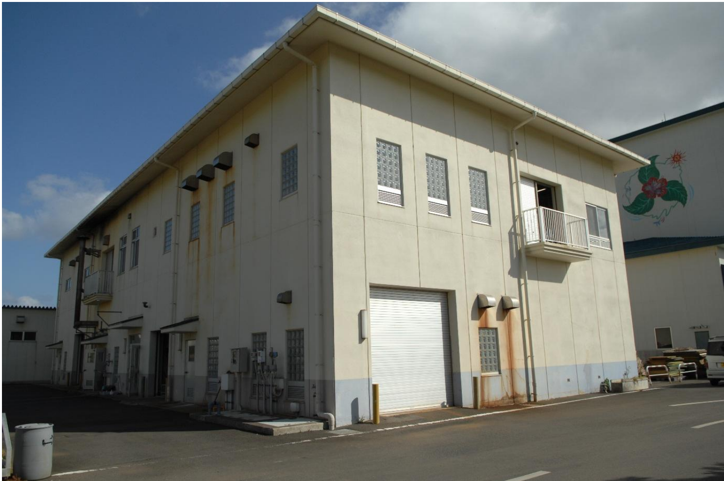
図1-21 浸出水処理施設
