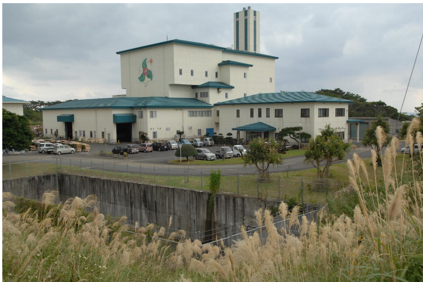
図1－11 徳之島愛ランドクリーンセンター
