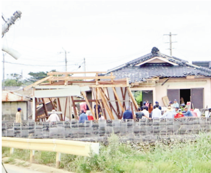
地域の方々による復旧作業
