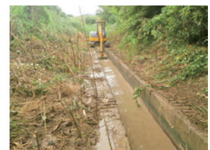
水路の泥上げ
