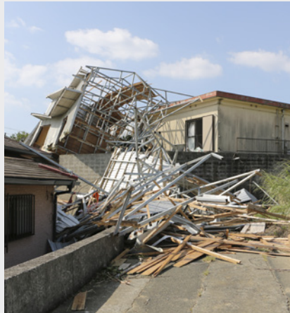
倒壊した建物が道路をふさぐ。
