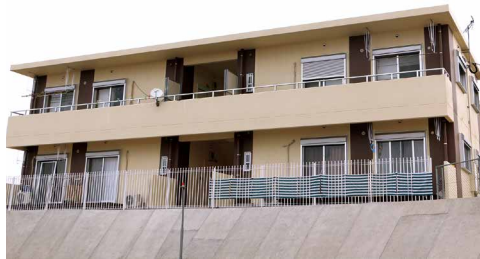
公営住宅の整備
