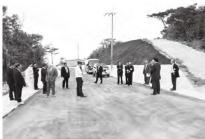
町道(第二西下線)の進捗状況調査(目手久地区)
