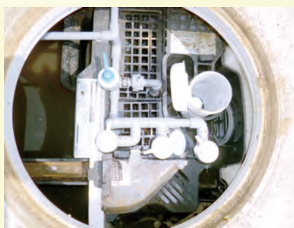
浄化槽の内部構造
