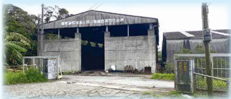
伊仙町堆肥センター
