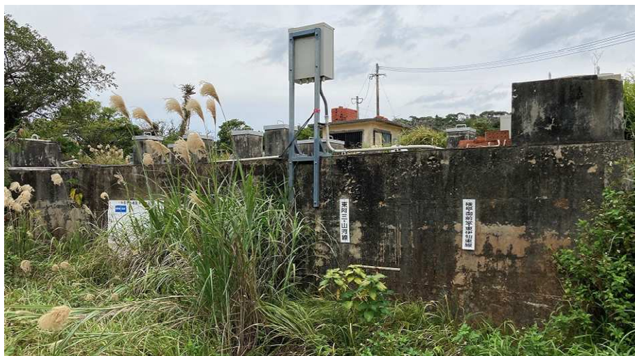
写-7 中部浄水場配水池（更新予定）
