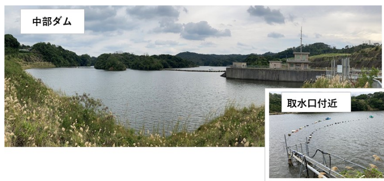
写-1 中部ダムと取水口
