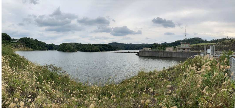
写-15 中部ダム水源地
