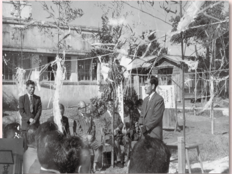
昭和 37 年 役場庁舎新築起工式
