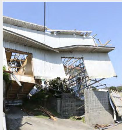
鉄骨が折れ曲がり倒壊した様子。
