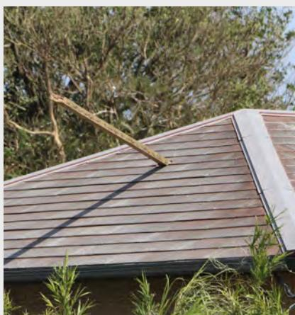
飛散した柱が屋根を貫通。
